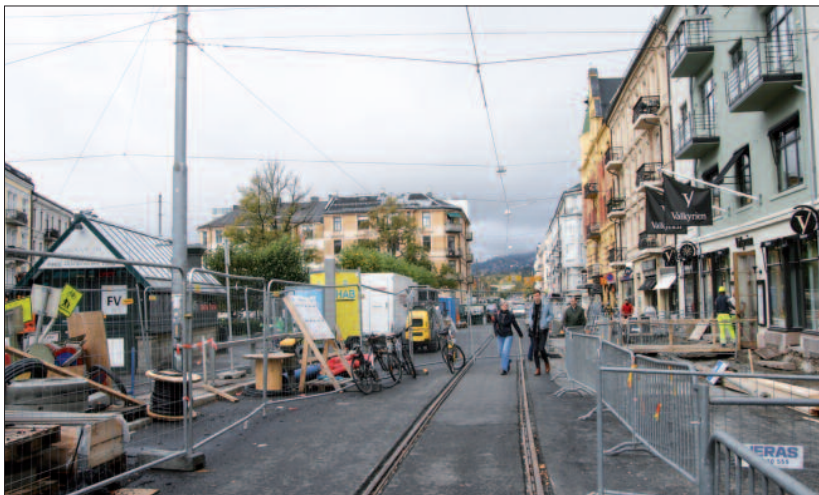
Intense byggearbeider i 2020 ...
