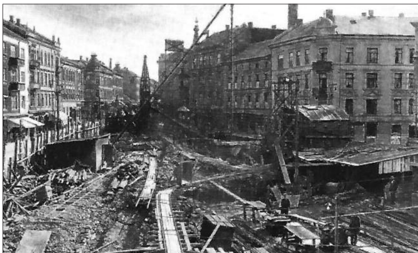
Litt av et hull!
