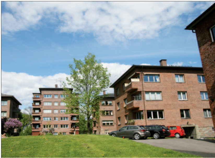
Fine teglgårder på Fredriksberg, Drammensveien 113–119, Halvdan Svartes gate 2–6 og Ingar Nilsens vei 1–7. Arkitekter: Leif & Ernst Torp. Foto s. 24–26: Bjørn Stendahl.
