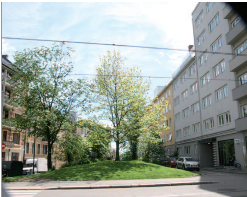
Frederik Stangs gate kiler seg inn i Skillebekk ved Drammensveien 70 C og Bjørn Farmanns gate 14–16.
